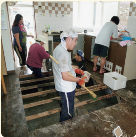
床下の泥だし
